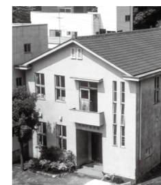
昭和57年 旧大磯町立図書館外観
