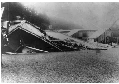
▲関東大震災で倒壊した大磯駅舎
