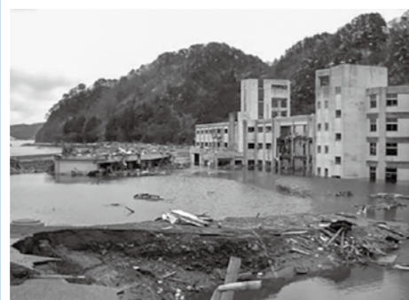
▲津波が去った後の釜石東中学校
