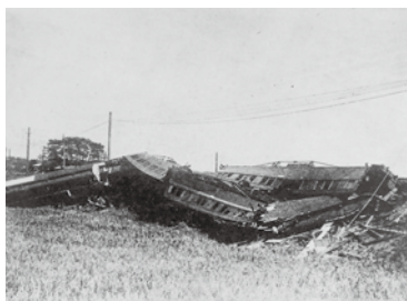
▲転覆した列車(『震災記録』より)
