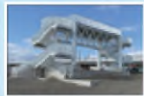
津波避難タワー
